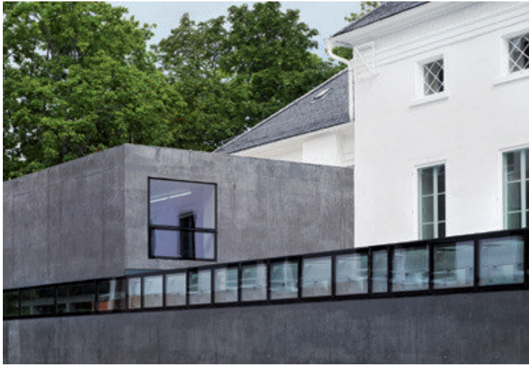
Der moderne Anbau betont kontrastierend den historischen Bestand des Museums Biedermann in Donaueschingen – gäbele & raufer Architekten BDA, Donaueschingen – Foto: Bernhard Strauss
