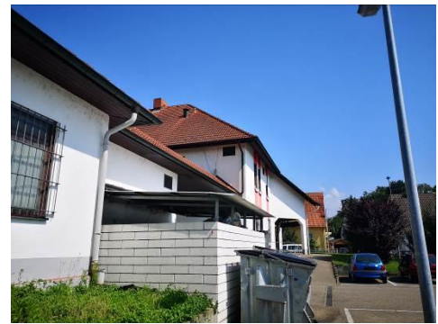
Abbildung 17 Südlicher Teil des Gebäudes auf Flst. 3488
